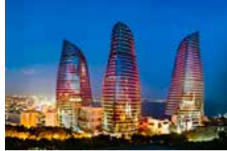
Flame Towers - Azerbejdżan - Mini Canal
