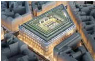
Poste du Louvre - Francja - Clima Canal
