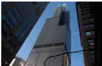
Willis Tower - USA - Clima Canal
